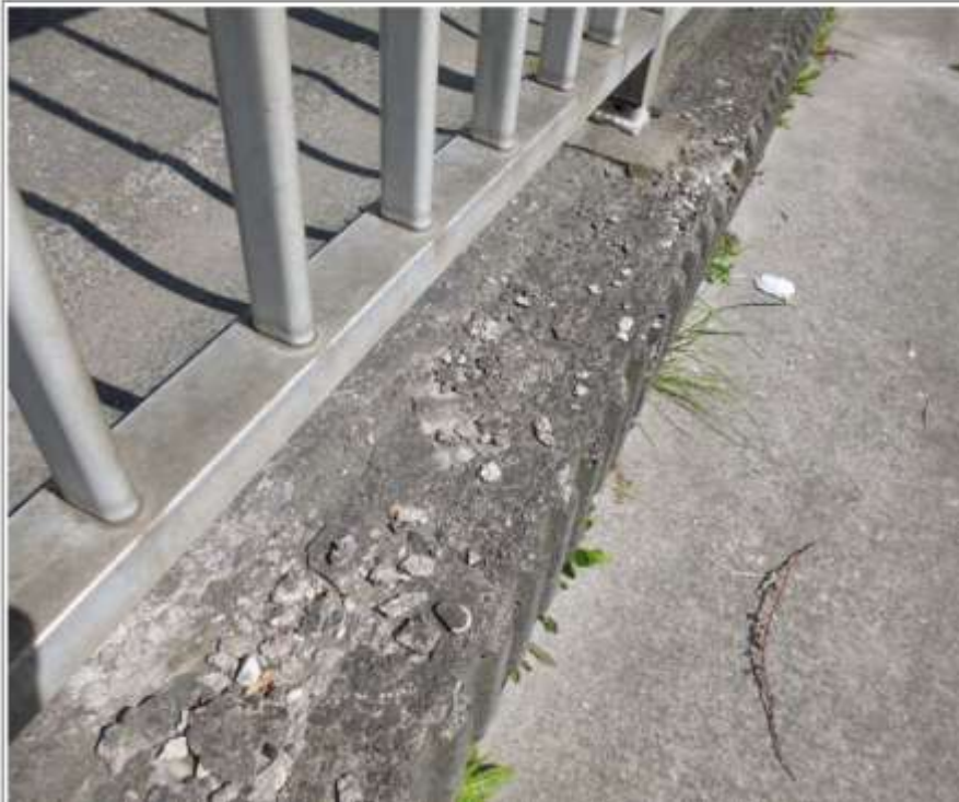
Beispiel: Rissbildungen teilweise mit Durchfeuchtung, Trogbauwerk Schnelser Weg
