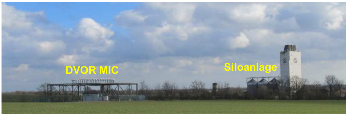
Abbildung 2: Siloanlage in direkter Umgebung des DVOR Michaelsdorf
