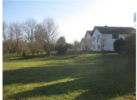
Abb. 4: Büro- und Lagergebäude; Ansicht von Norden; © Krauß
