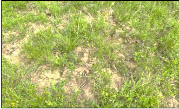
Abbildung 7: Trittbelasteter Böschungsbe- reich
