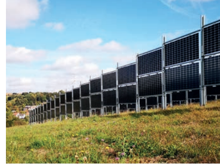
Abb. 39: Bifaziale, senkrecht aufgestellte Module von Next2Sun, Eppelborn-Dirmingen. © Next2Sun GmbH
