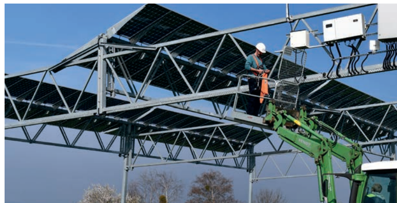
Abb. 54: Wartungsarbeiten an der Agri-PV-Anlage in Heggelbach. ©Fraunhofer ISE
