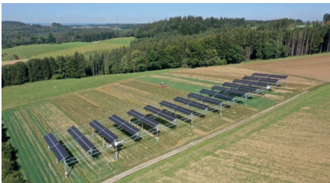
Abb. 50: Agri-PV-Anlage in Heggelbach mit einer Leistung von 194 kW p auf etwa einem Drittel Hektar. © Fraunhofer ISE
