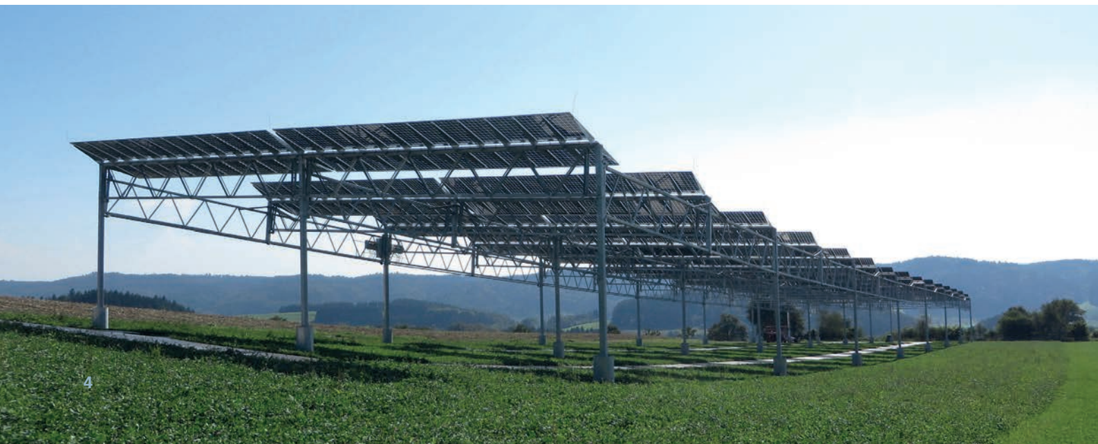
Abb. 1: Agri-PV-Forschungsanlage am Bodensee. © Fraunhofer ISE
