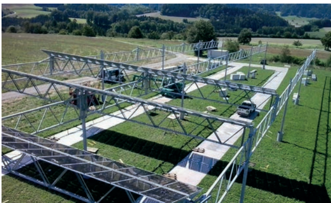
Abb. 53: Baustraßen zur Vermeidung von Bodenverdichtung. © BayWa r.e
