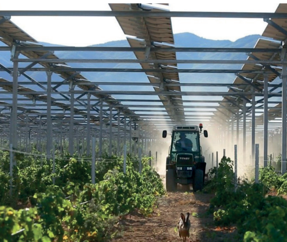
Abb. 44 Hoch aufgeständerte Anlage mit durchgängigen Modulreihen. © Sun'Agri
