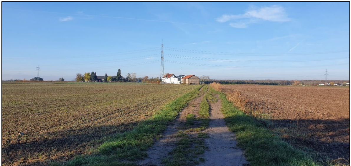
Abb. 18: Sicht auf Leitungstrasse vom bestehenden Siedlungsrand (Foto Planungsgruppe Darmstadt)
