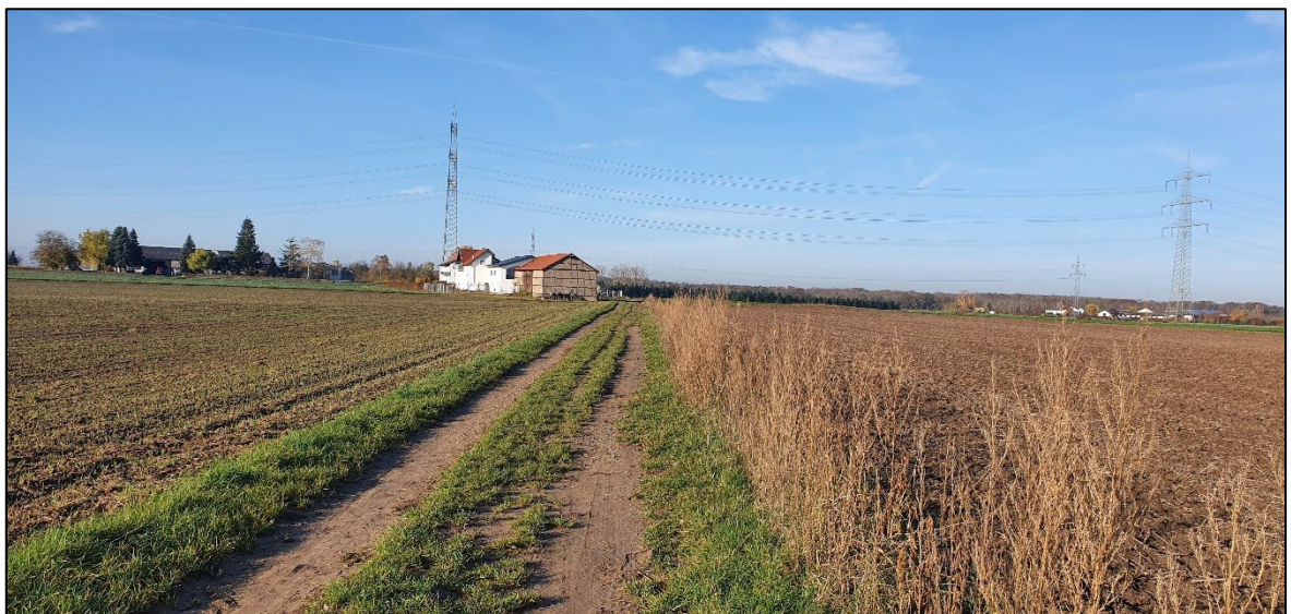
Abb. 20: Sicht auf Leitungstrasse in einer Entfernung von ca. 400 m (Mindestabstand 3. LEP-Änderung 2000 Hessen) (Foto Planungsgruppe Darmstadt)
