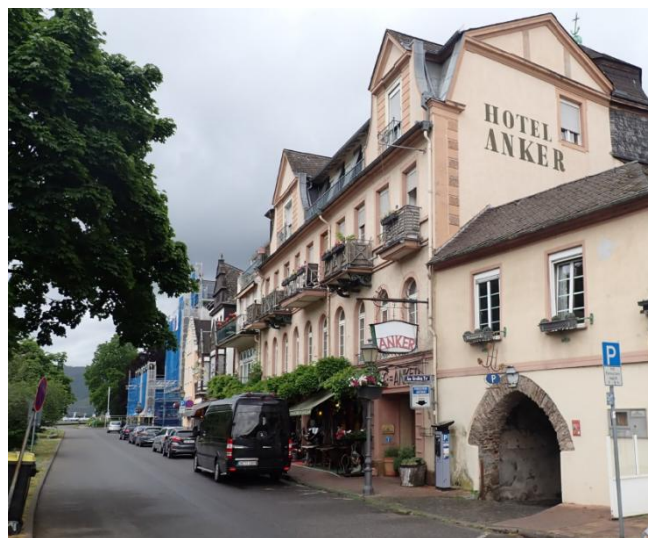
Abbildung 4-9: Rheinuferstraße, Blick in Richtung Norden
