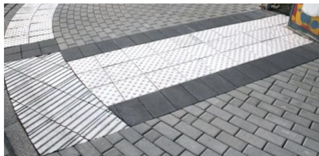
Abbildung 4-7: In Gehrichtung verlegte Rippenelemente als Bodenindikatoren des taktilen Systems, Noppenelemente an der Bordsteinkante als Abtrennung zur Fahrbahn am oberen linken Bildrand
