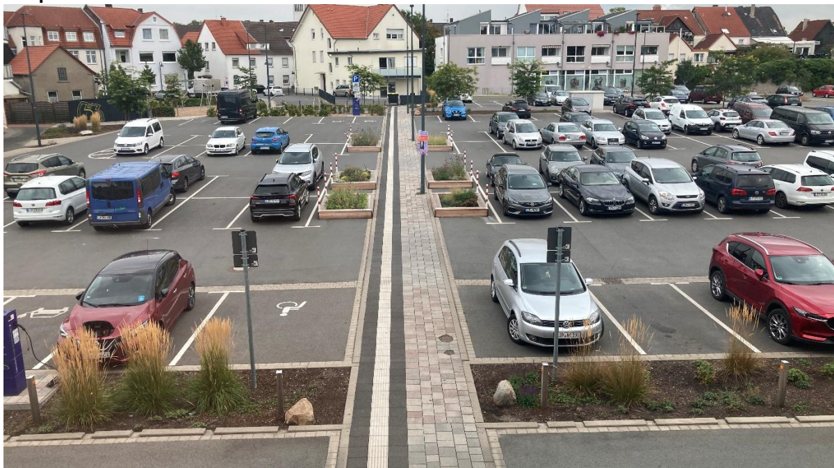
Abbildung 4-6: Beispiel für eine gesicherte Führung des Fußverkehrs, hier über einen Parkplatz in Lage (Lippe)
