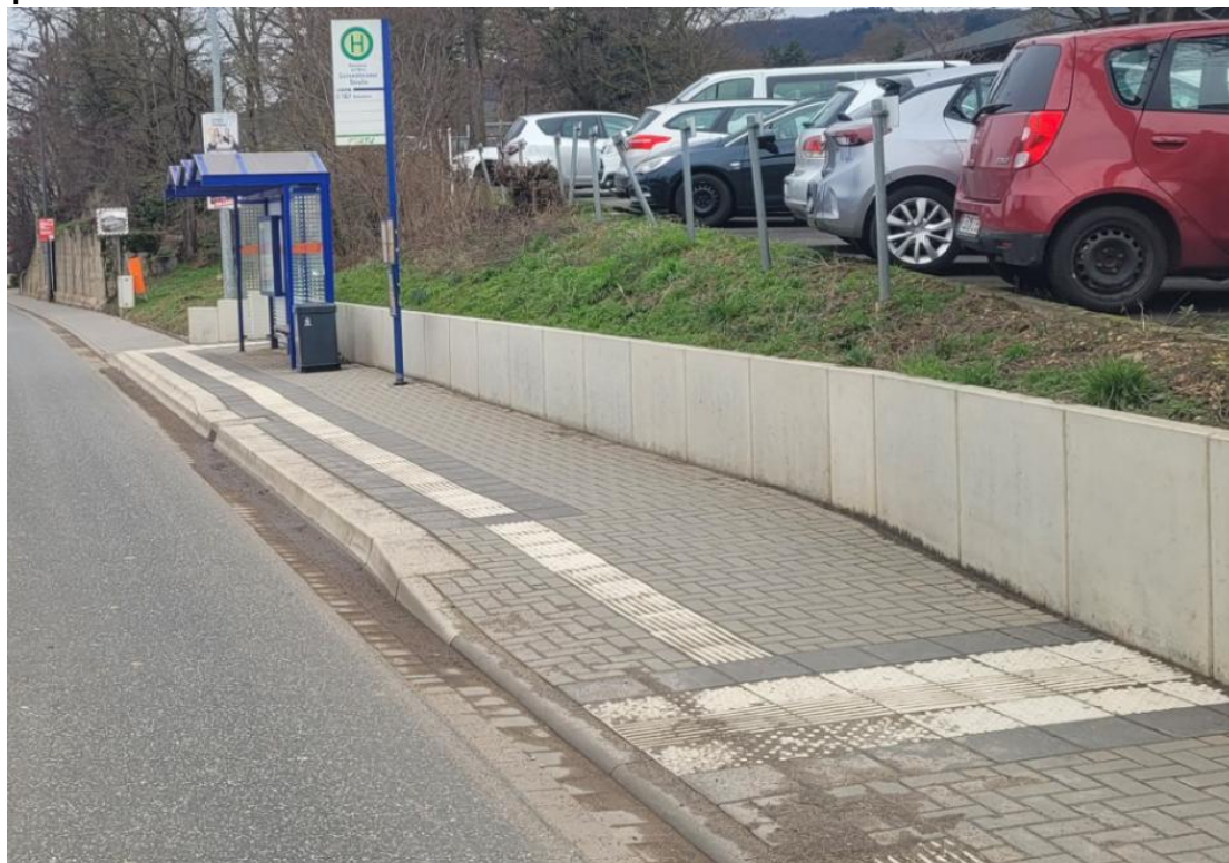
Abbildung 4-8: Barrierefreier Haltestellenausbau Rüdesheim, Geisenheimer Straße (Foto: mociety)
