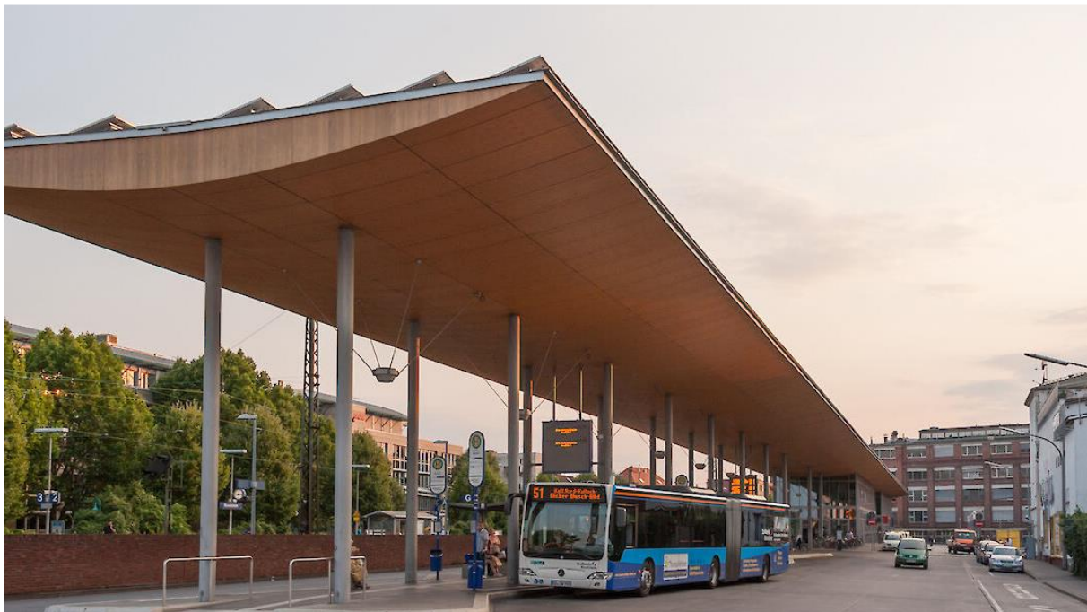
Abbildung 14: Endstelle „Rüsselsheim Bahnhof“
