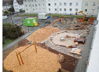
Blick von oben auf die Außenanlage der Kita.
