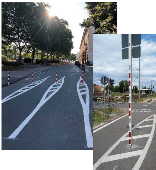
Abbildung: Warnmarkierung Sperrpfosten und reflektierender Mast
