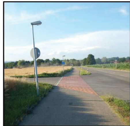
Abbildung: Straßenbegleitender Radweg im Querungsbereich in Kirchheimt unter Track
