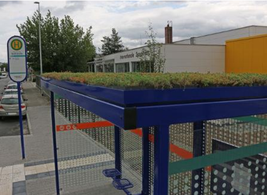
Abb. 26 Dachbegrünung am Warthhäuschen an der Stahlstraße
