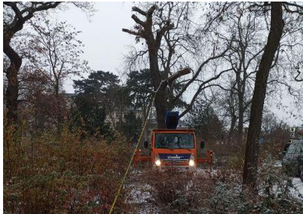
Abb. 44 Sicherheitsprüfung an abgestorbener Eiche
