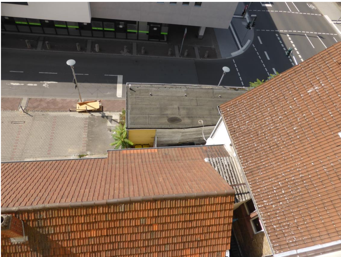
Abb. 20: Gebäude an der Löwenstraße von oben
