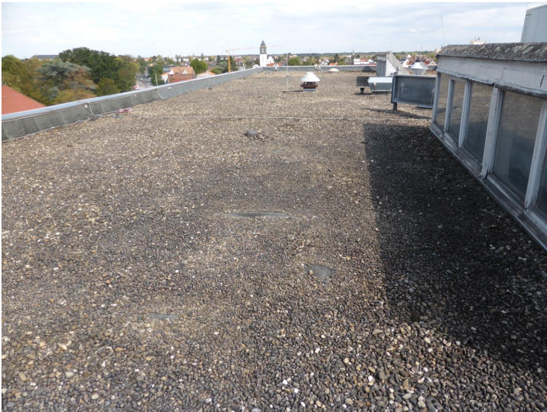
Abb. 14: Kiesbedeckung auf dem Flachdach des Karstadtgebäudes
