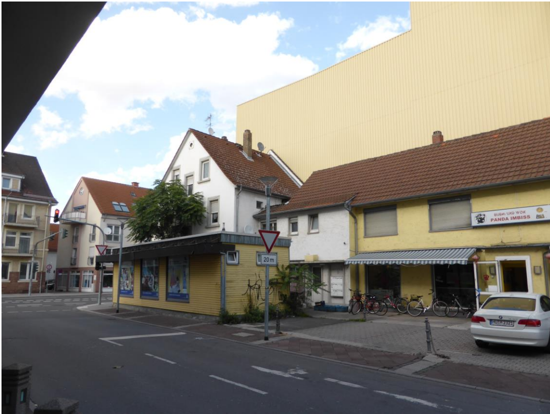
Abb. 5: Abrissgebäude an der Löwenstraße, im Hintergrund das Karstadtgebäude
