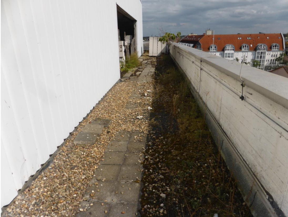
Abb. 13: Hintere Dachfläche mit aufgesetztem Gebäudeteil, Blechabdeckung auf Mauerkranz.
