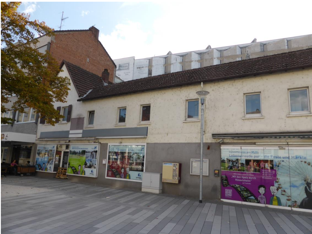
Abb. 4: Abrissgebäude am Friedensplatz
