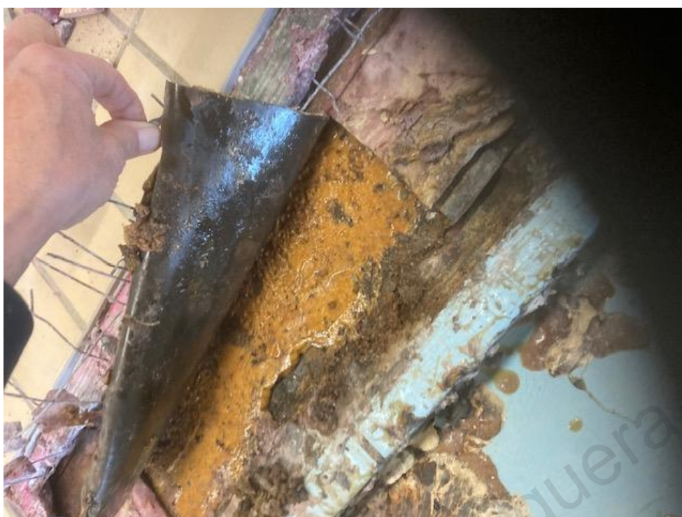
Bauteilöffnung Beckenumgang
