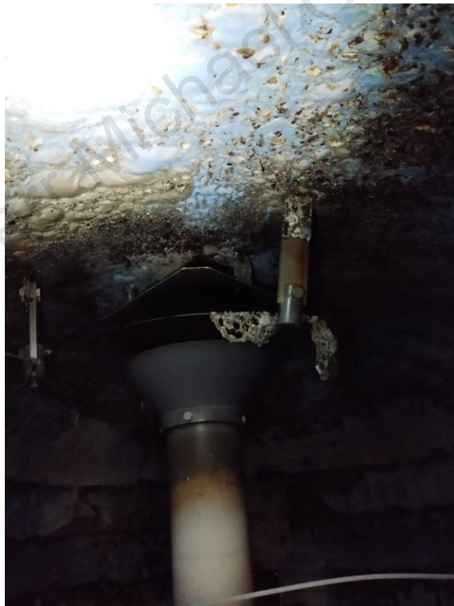
Blasenbildung unter der Beschichtung
