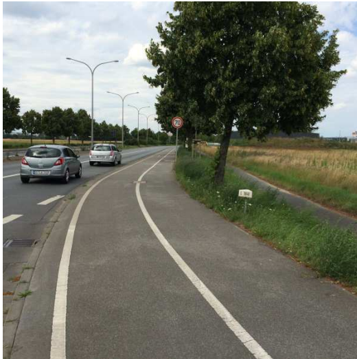
Abb. 11 Blick auf die L 3040 und Rad-/ Gehweg in nördliche Richtung
