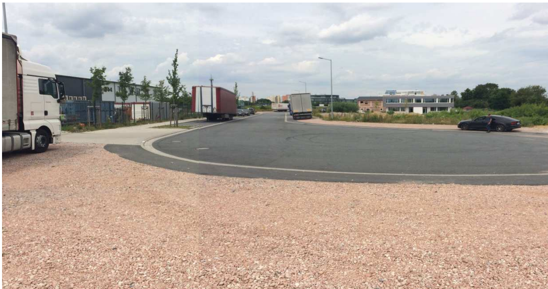
Abb. 10 Blick auf die nördlich des Plangebietes bestehende Wendeanlage mit Gewerbegebiet
