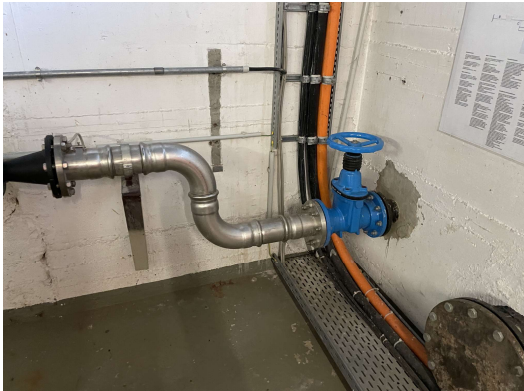
Trinkwasser-Hausanschluss (neu)
