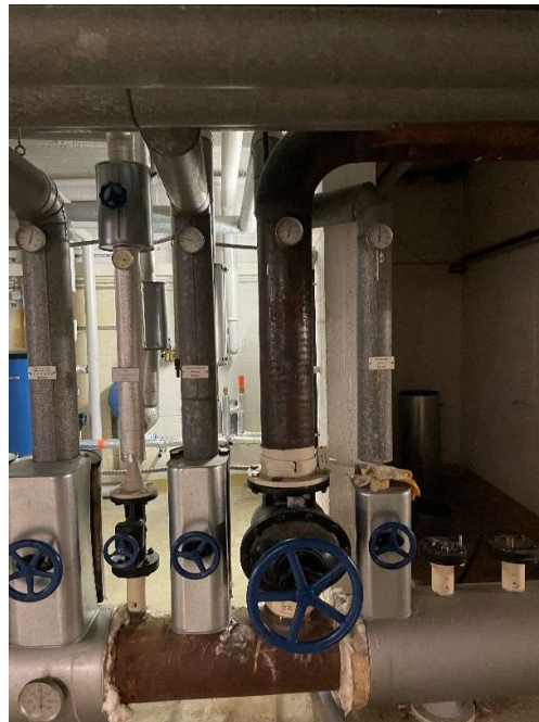
Heizungssammleranlage (alt)
