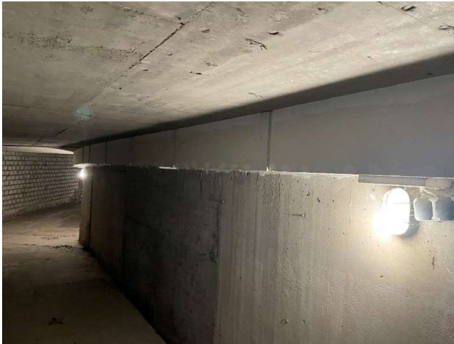
Außenluftansaugkanal
