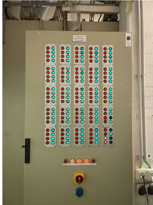
Schaltschrank Brandschutzklappen
