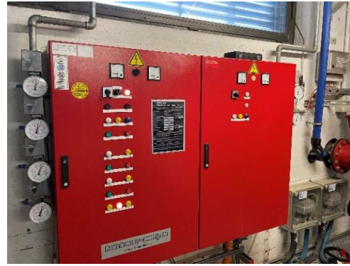
Sprinklerpumpenschaltschrank (Sprinklerzentrale)
