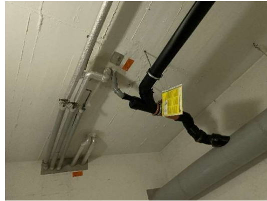
Entwässerungsleitung - Mischinstallation
