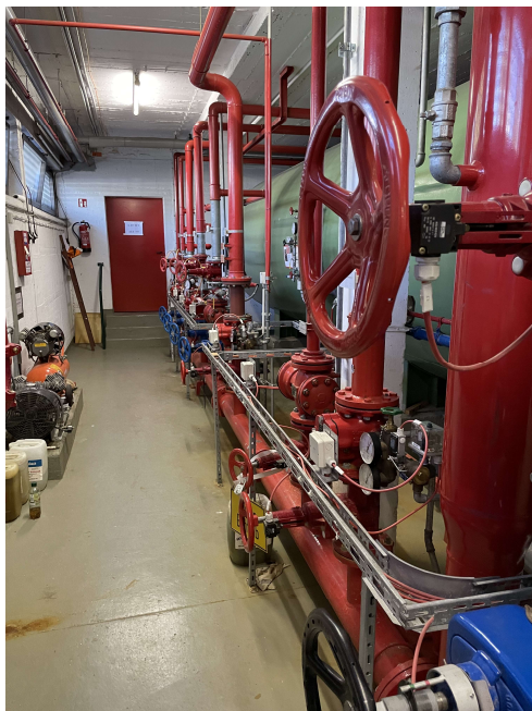
Sprinklerverteiler (Sprinklerzentrale)
