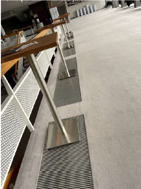
Unterflurkonvektoren (Foyer)
