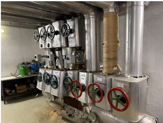
Kaltwasserverteiler (Brunnenwasser)
