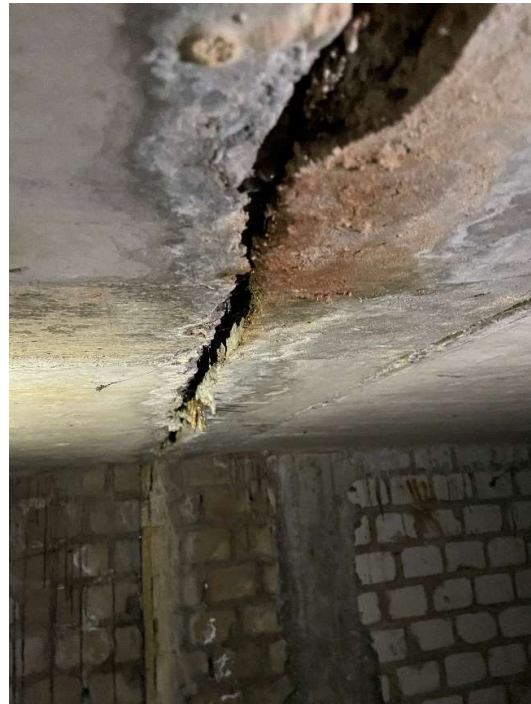
Außenluftansaugkanal (Bauschaden)
