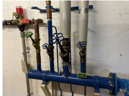
Trinkwasserverteiler (alt)
