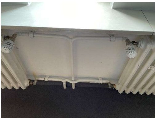
Heizkörperanschlüsse
