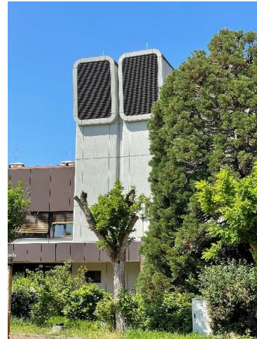
Außenluftansaugbauwerk
