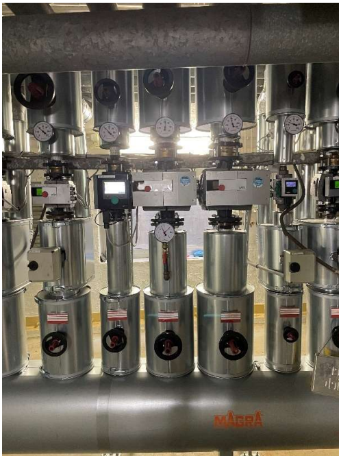
Heizungsverteileranlage
