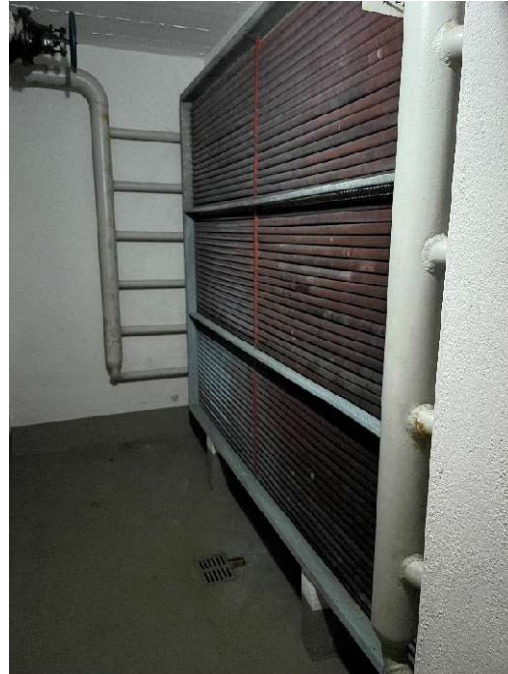
Erhitzeranschluss RLT-Zentralgerät
