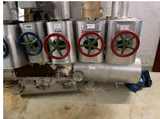
Kaltwasserverteiler (Brunnenwasser)
