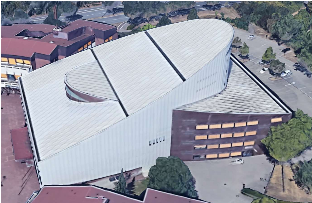
Dachflächen mit integrierten Rinnen – Quelle: Google Earth
