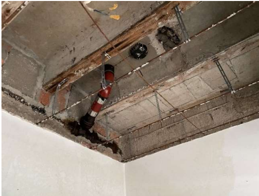
Entwässerungsleitungen in Sanitärbereichen
