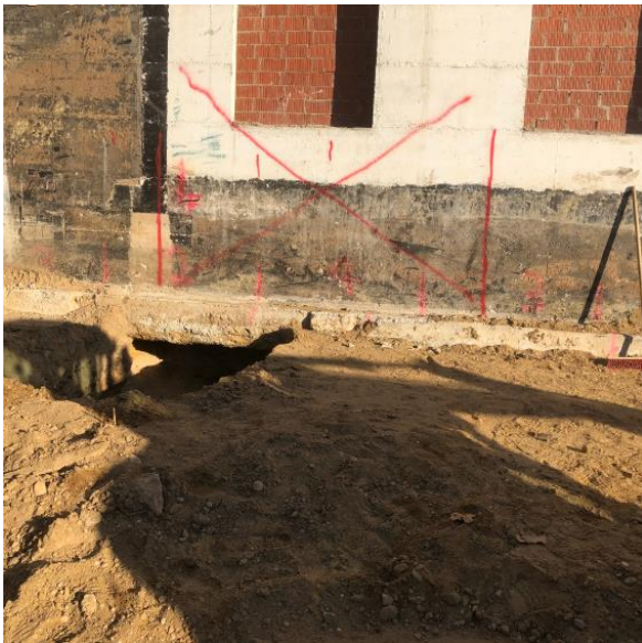
Fehlende Unterfangung Bestandsgebäude Westflügel
