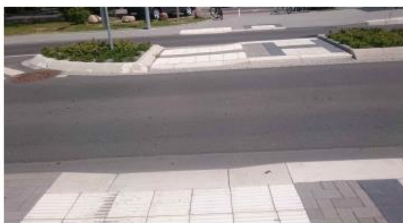
Abb. 37: Ungesicherte Überquerungsstelle mit Mittelinsel in Groß-Gerau.
