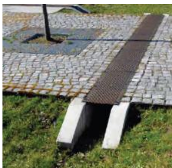
Abbildung 36: Beispiel: Durchlass und Retentionsfläche
