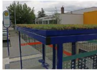
Abb. 26 Dachbegrünung am Warthhäuschen an der Stahlstraße
