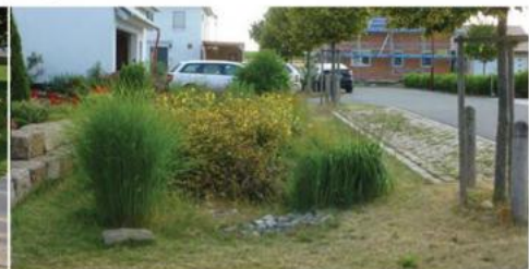
→ Abb. 14 Straßenbegleitende Versickerungsmulden
