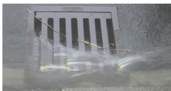
Abbildung 10: Überlasteter Straßeneinlauf
