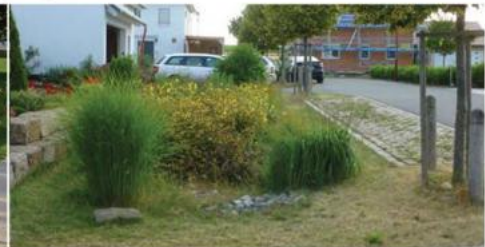
→ Abb. 14 Straßengeleitende Versickerungsmulden
