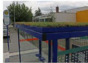
Abb. 26 Dachbegrünung am Wartehäuschen an der Stahlstraße
