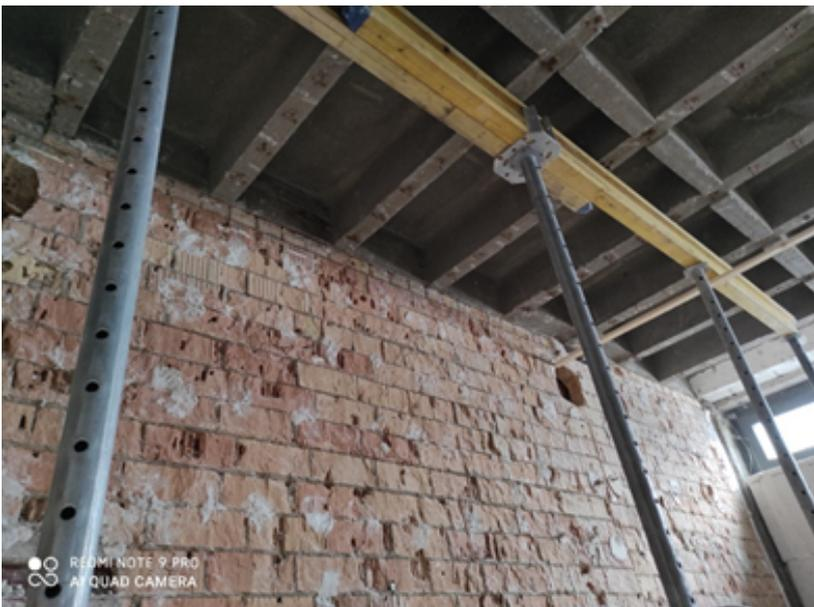
Nach Rückbau der Ver- und Entsorgungsleitungen in den Wänden ist darüber hinaus in Teilbereichen ein mangelhafter baulicher Zustand der Bestandsmauerwerkswände zu Tage
