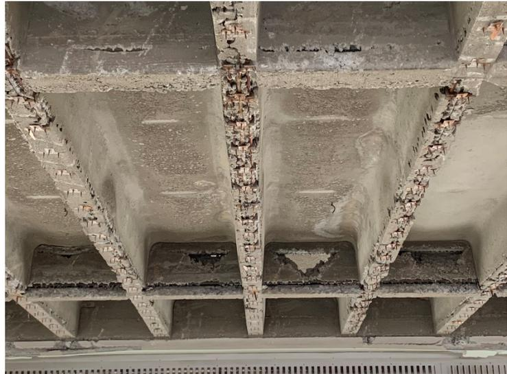
Nach Rückbau der Holzverschalungen wurde im südlichen Gebäudeteil von der Objektüberwachung und vom Statiker „Gefahr in Verzug“ gemeldet, da über das bis dahin bekannte Schadensausmaß hinaus eine massive Beeinträchtigung der Standsicherheit der Decken und der gesamten Gebäudeteile festgestellt wurde, einhergehend mit einer erheblichen Verkehrsgefährdung durch herabstürzende Bauteile.
