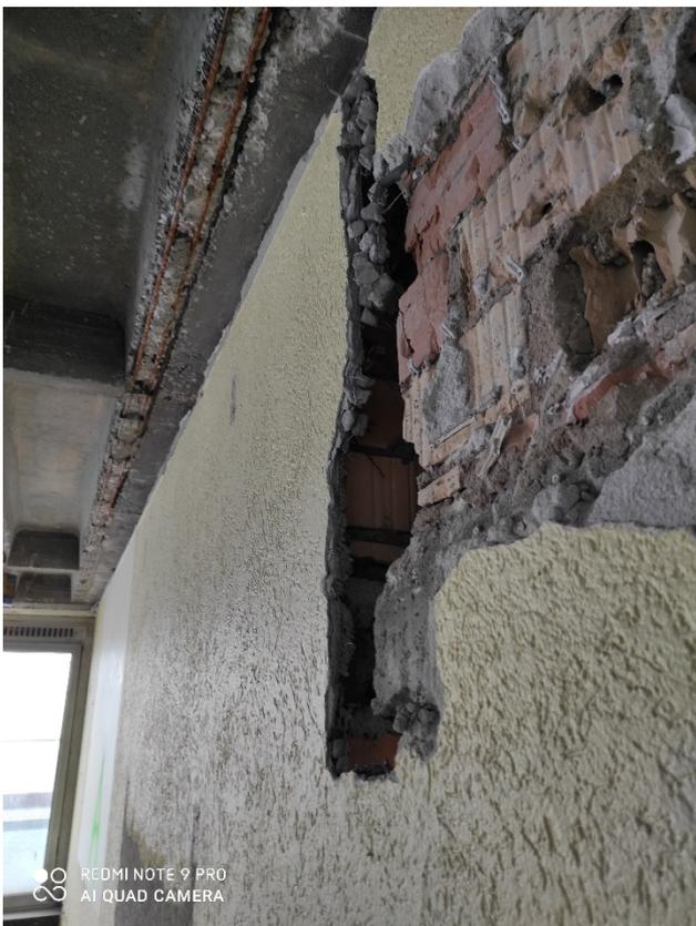
Nach Rückbau der Holzverschalungen für die Rippendeckensanierung ist des Weiteren in Teilbereichen ein mangelhafter baulicher Zustand der unteren Ansicht der Dächer zu Tage gekommen, dessen Ausmaß erst nach vollständiger Entfernung des oberen Dachbelags im Vorbereitung zu den Dachdeckerarbeiten ab ca. November 2021 erkennbar sein wird.
