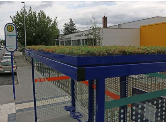
Abb. 26 Dachbegrünung am Warthhäuschen an der Stahlstraße
