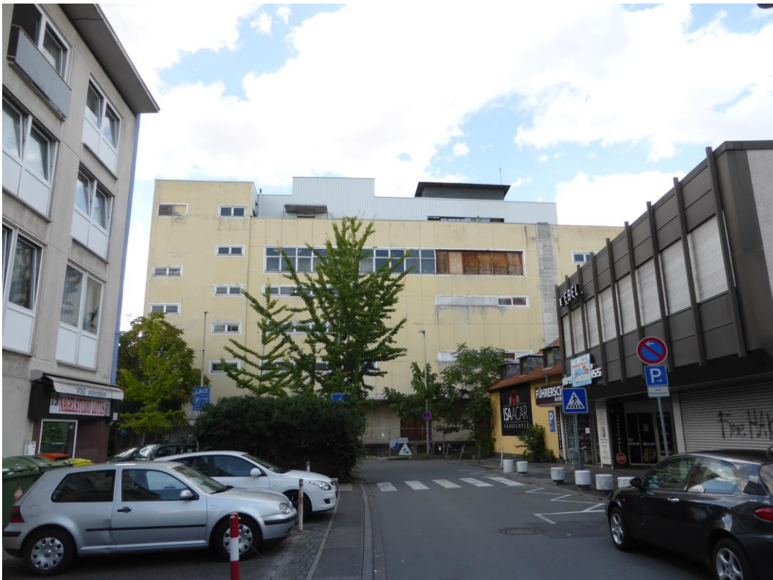
Abb. 2: Rückansicht des Karstadtgebäudes, Blick nach Norden
