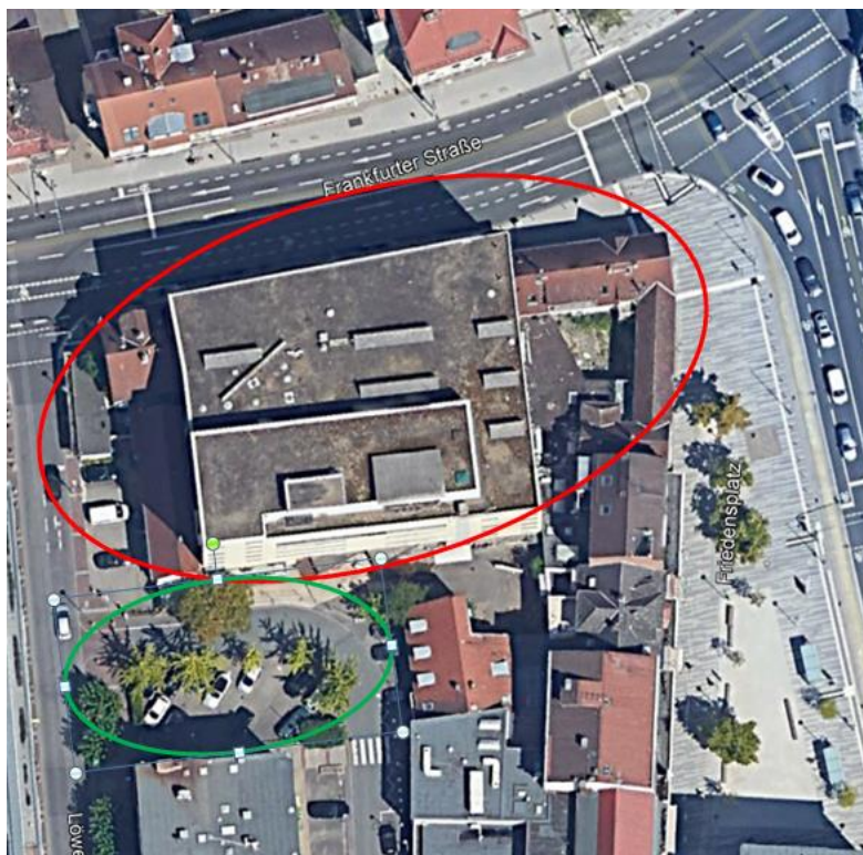
Abb. 1: Luftbild des Plangebiets. Abrissgebäude im roten Oval, Parkplatz in grün. Luftbildquelle: Google Earth.
