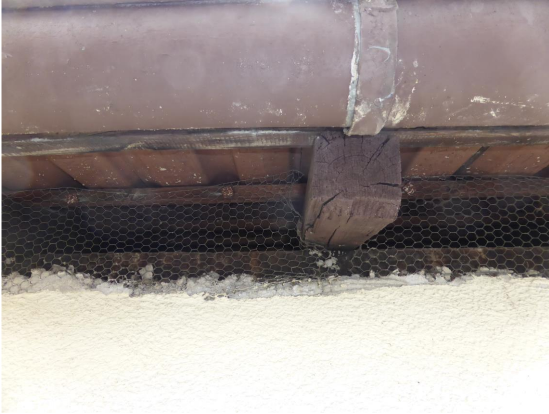
Abb. 19: Vergitterung unter der Dachrinne vom Innenhof aus zum Fernhalten von Spatzen
