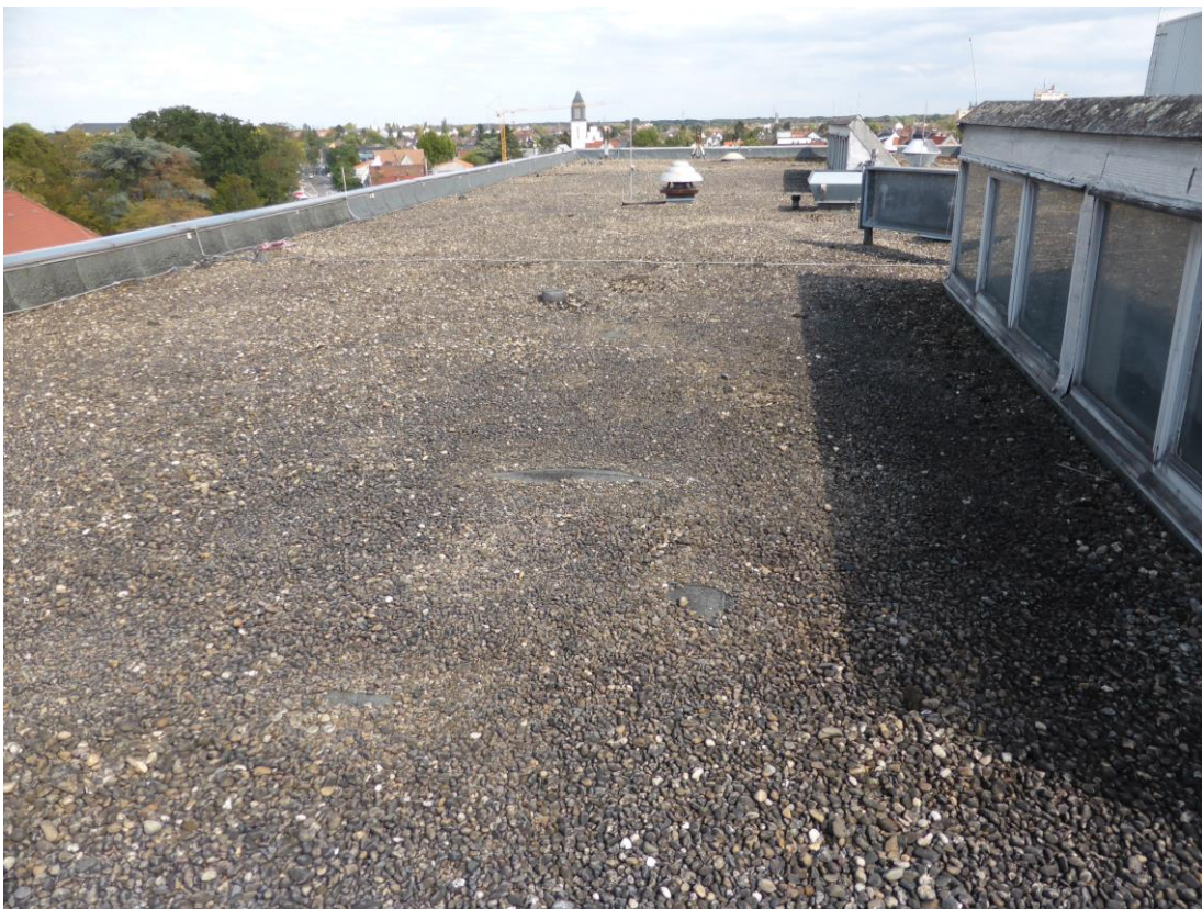
Abb. 14: Kiesbedeckung auf dem Flachdach des Karstadtgebäudes
