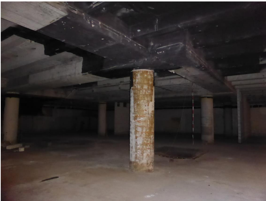
Abb. 8: Kellerräume des Karstadtgebäudes
