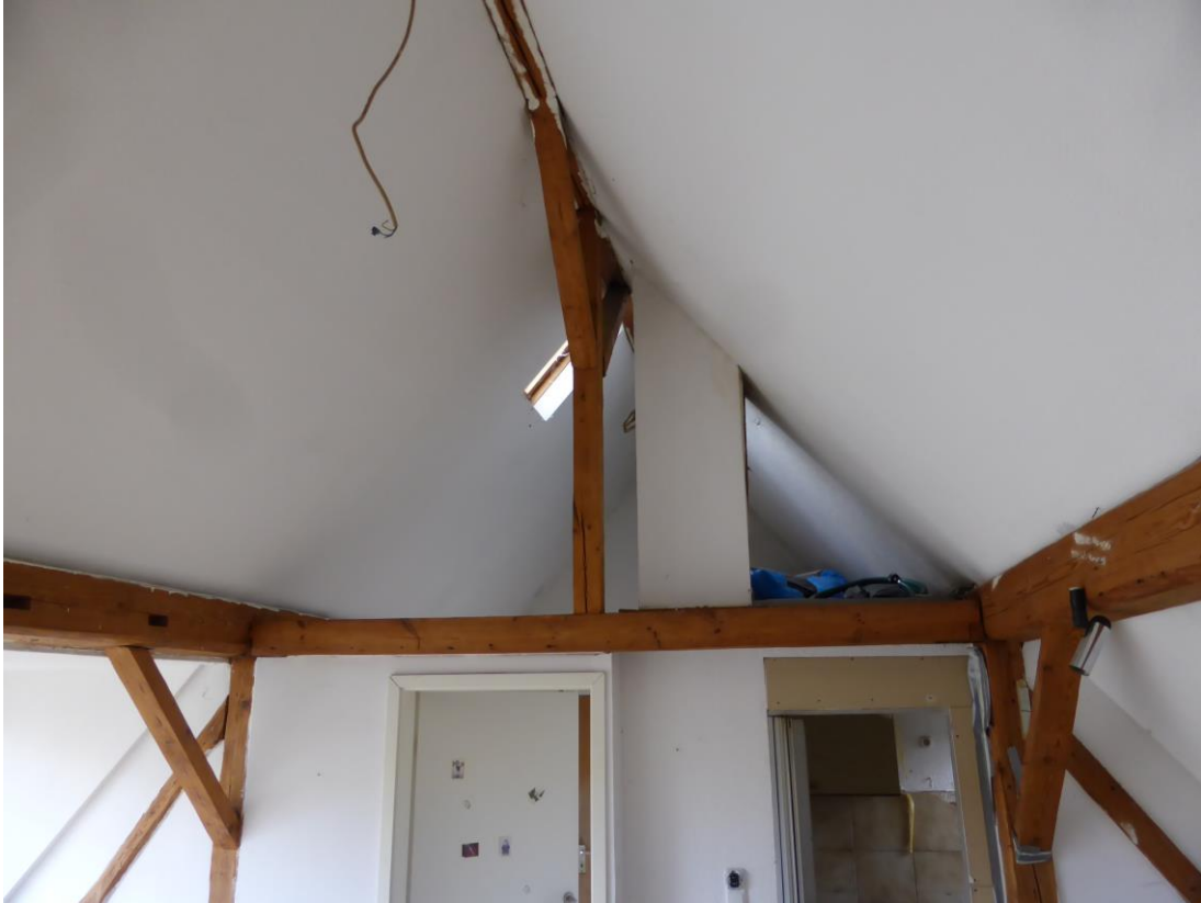
Abb. 17: Innenausbau des Gebäudes bis in die Dachräume
