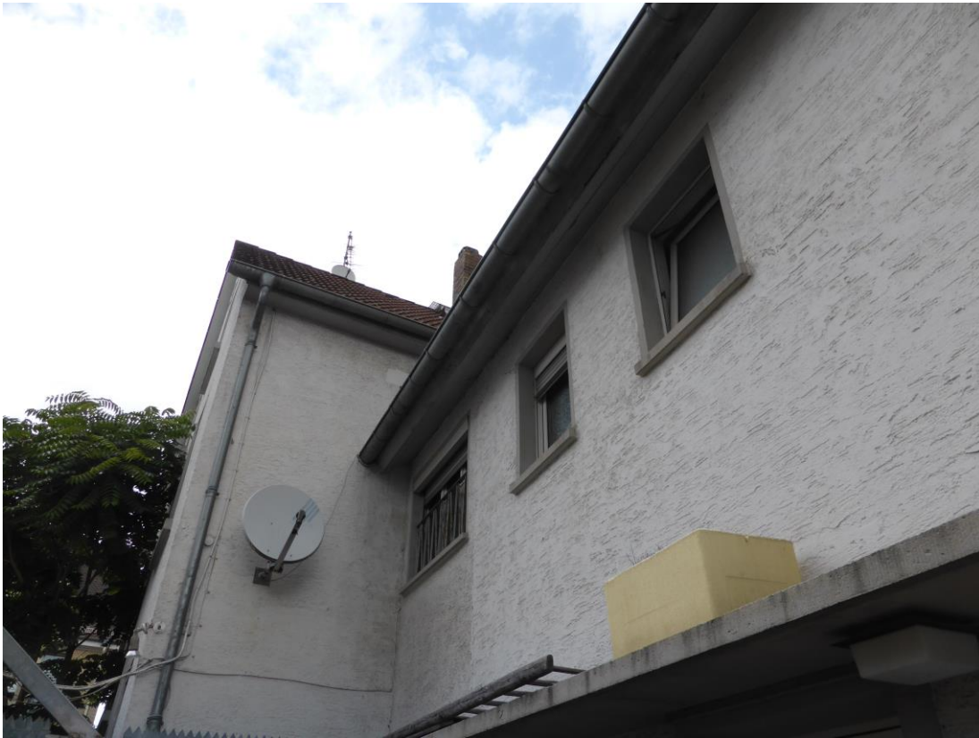
Abb. 21: Glatte Fassade der Gebäude an der Löwenstraße ohne hinterfliegbare Strukturen
