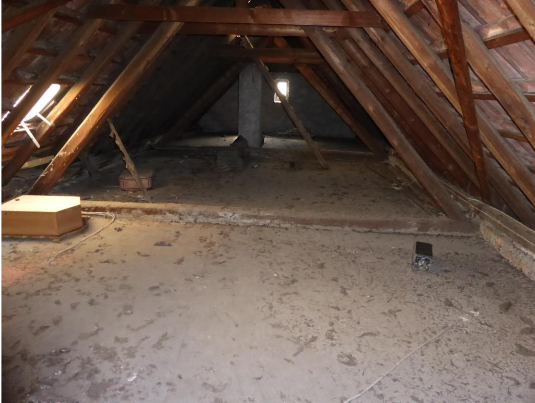
Abb. 23: Leer stehender Dachraum, übersichtlich und ohne Anzeichen von Tierbesiedlung
