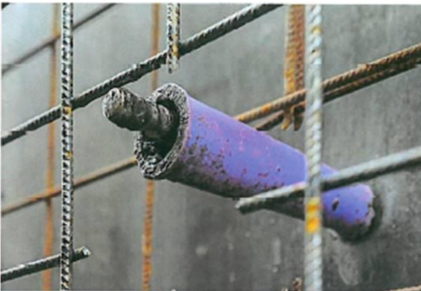
Asbesthaltige Abstandshülse (nur Beispiel, nicht von der Alexander-von-Humboldt-Schule)
