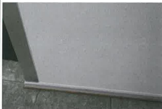
Foto 2: wie Foto 1, Ausblühungen auf der Wandfläche in Folge erhöhter Feuchte
