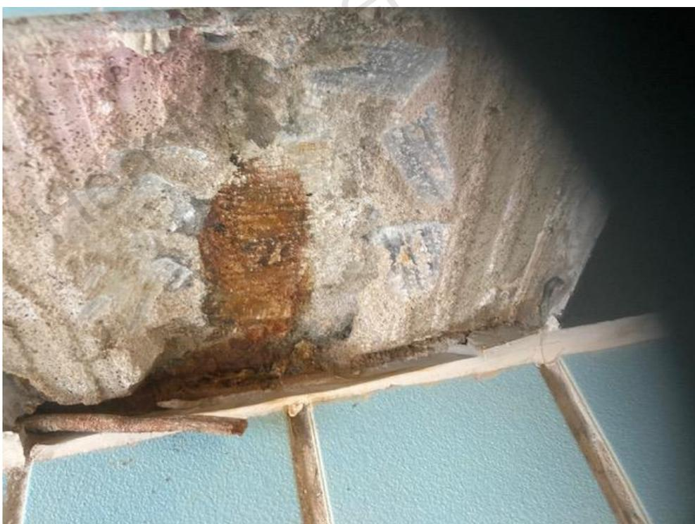
Bewehrungskorrosion Beton Schwimmbecken Innenseite
