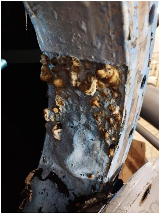
Ablagerungen am Mannloch (Wartungsöffnung am Filter)
