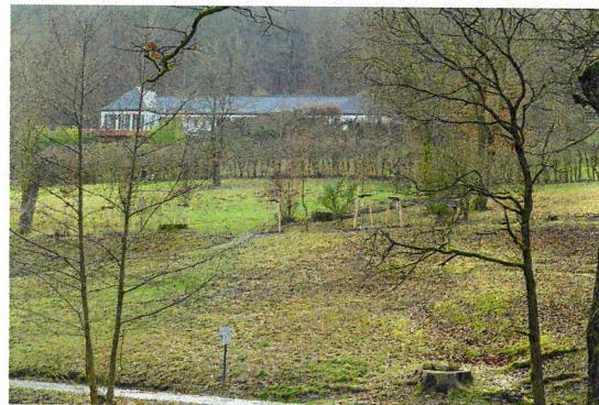
Thermalfreibad, Nassauer Allee 1, Ansicht von Norden, Zustand Februar 2022 (Foto: Sonja Bonin, LfDH)
