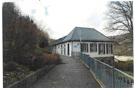
Thermalfreibad, Nassauer Allee 1, Ansicht von Südosten, Zustand Februar 2022 (Foto: Sonja Bonin, LfDH)
