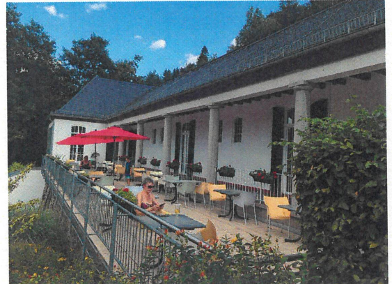
Thermalfreibad, Nassauer Allee 1, Ansicht von Nordwesten, Zustand August 2022 (Foto: Sonja Bonin, LfDH)
