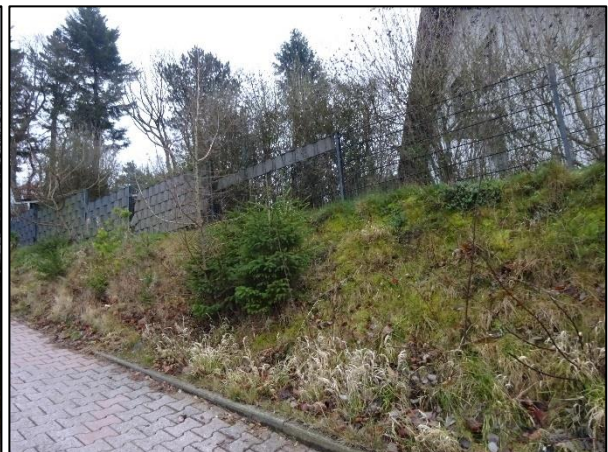
Abbildung 5: Blick auf die begrünte Zufahrt des Plangebiets.
