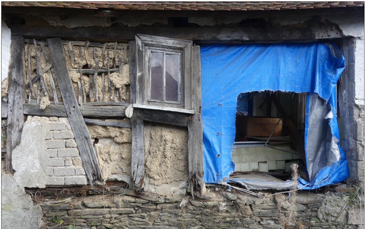
Abb. oben: Traufwand nach Westen, südlicher Abschnitt
