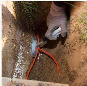
Ein kleines Loch von 16 mm Durchmesser wird in die Hauswand gebohrt und die **Glasfaser durchgeführt**. Anschließend wird das Loch wieder luft- und wasserdicht verschlossen.
