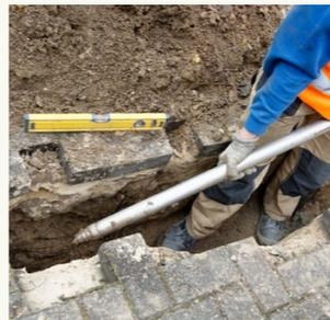
Die Glasfaser wird i. d. R. mithilfe der sog. „Erdrakete“ mittels Luftdruck unterirdisch zur Hauswand geführt (ca. 15 m pro Stunde). Wir öffnen somit nur einen schmalen Streifen in Ihrer Einfahrt bzw. Vorgarten. **Kommen bauliche Alternativen zum Einsatz, besprechen wir diese im Vorfeld mit Ihnen.**
