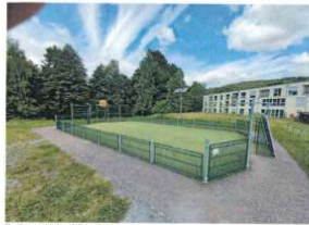
Ein Gesamtblick auf die Anlage
