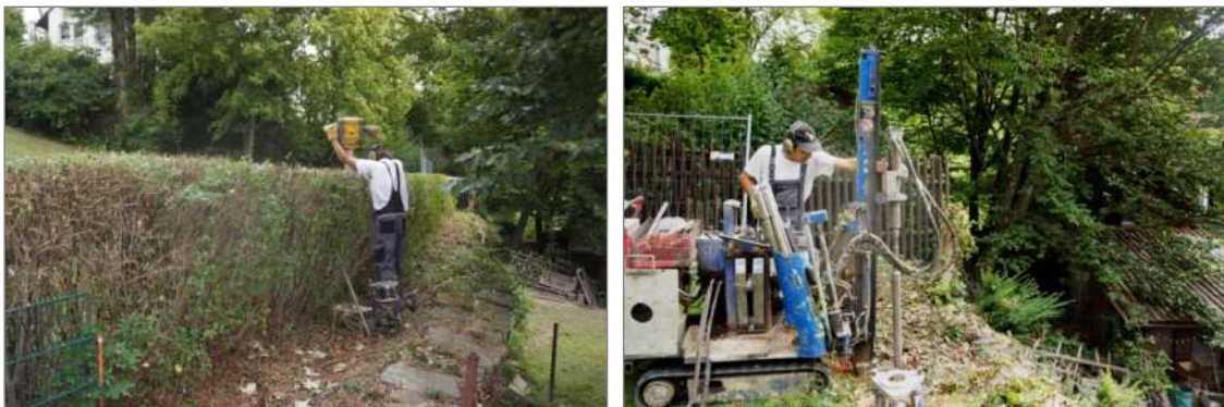
Abbildung 8: Durchführung der Bohrsondierung BS 1
