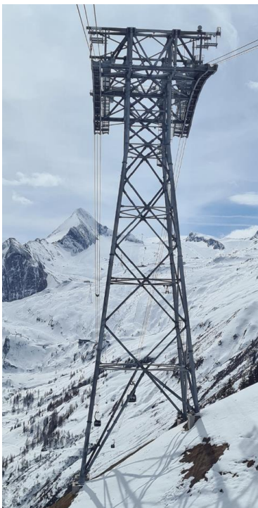
Abbildung 40: Fachwerkstütze 3S Kitzsteinhorn [28]
