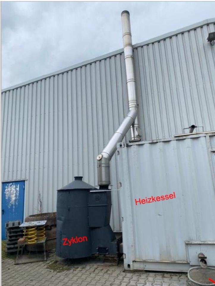
Die Rauchgase werden bezüglich Feinstaubreinigung über einen Zyklon und danach mittels Schornstein über Dach abgeführt. Übrig bleiben in der Woche 3 Eimer Asche (siehe unten).
