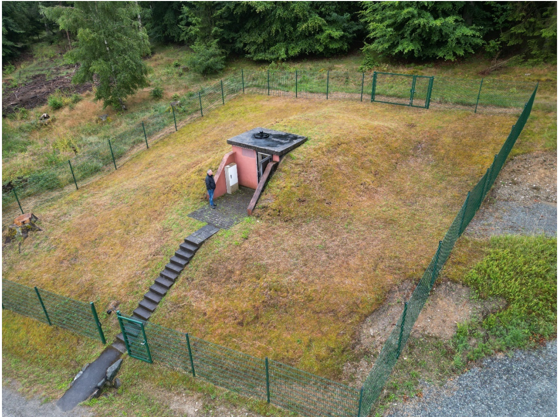
Abb. 1: Fassungsbereich des Brunnen Dillenberg in Hanglage
