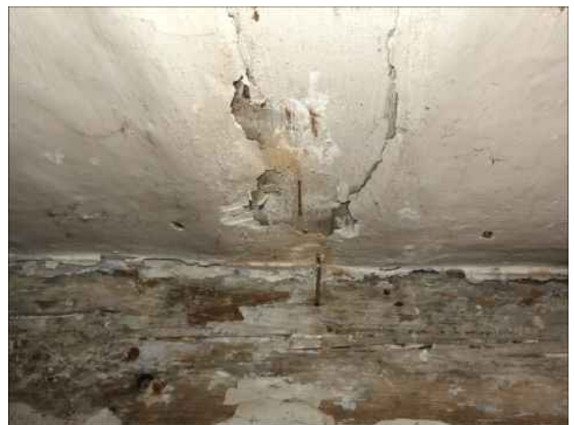
Abb. oben links: Historische Holzverkleidung nach Abnahme neuzeitlicher N+F-Bretter im Dachgeschoss Abb. oben rechts: Historische Holzverkleidung nach Abnahme neuzeitlicher N+F-Bretter im Flur Abb. unten links: Dreiflügeliges Fenster der frühen Nachkriegszeit Abb. unten rechts: Deckenputz mit verputzten Balken nach Abnahme Deckenverkleidung
