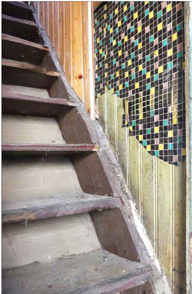
Abb. links: Bauzeitliche Einschubtreppe mit Holzverkleidung des 19. Jh. Abb. oben rechts: Historische Postkarte von 1904 Abb. unten rechts: Ansicht von Südosten, Foto der 1930er-Jahre
