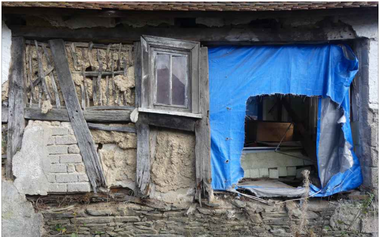
Abb. oben: Traufwand nach Westen, südlicher Abschnitt
