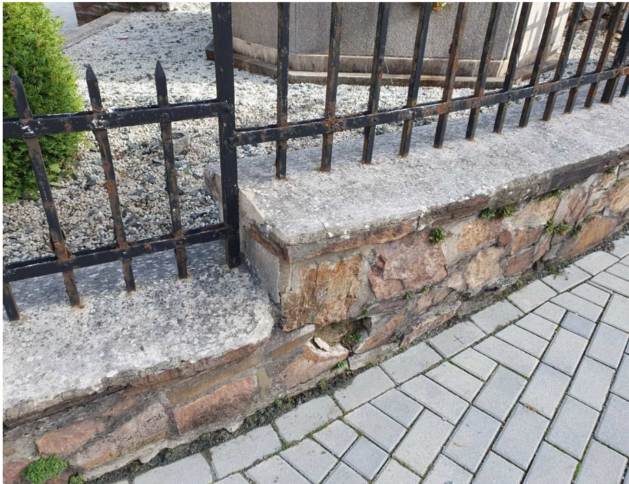
Defekte Bruchsteinmauer
