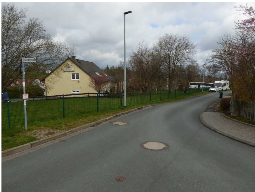
Bild 6: Blick auf einen Teilbereich des Bewertungsobjekts aus südöstlicher Richtung
