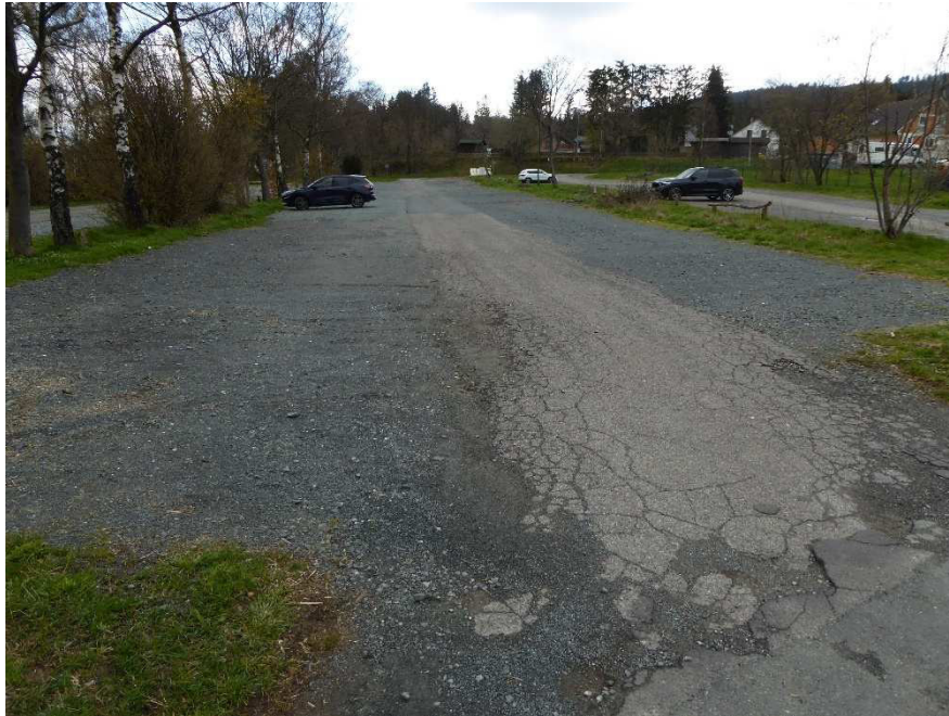
Bild 3: Blick auf einen Teilbereich des Bewertungsobjekts aus westlicher Richtung
