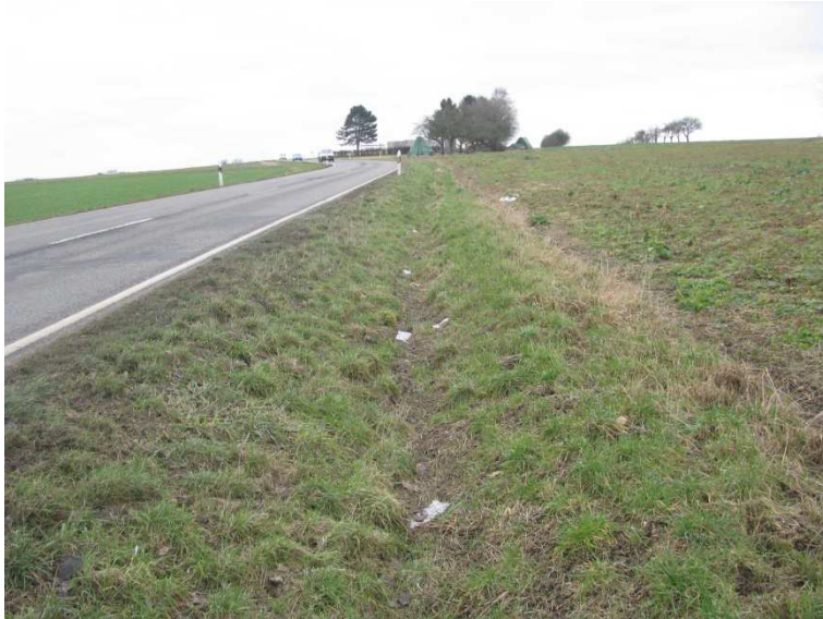
Abb. 9: Entwässerungsgraben, nördlich Sodener Straße, Blickrichtung Westen
