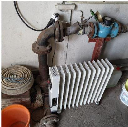
Hauswasseranschluss mit Zähler
