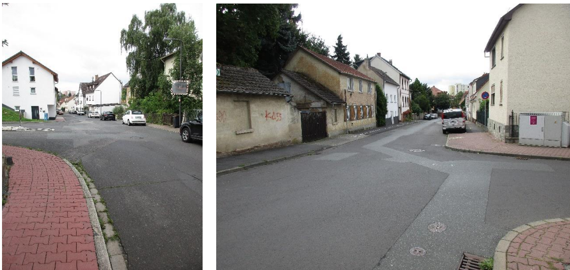
Abb. 37: Bestandssituation Bornhohl (beispielhaft), eigene Aufnahmen werkplan, August 2021
