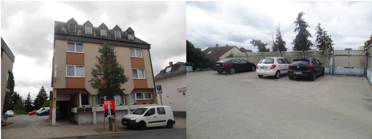
Abb. 43: Bestandssituation, eigene Aufnahmen werkplan, August 2021
