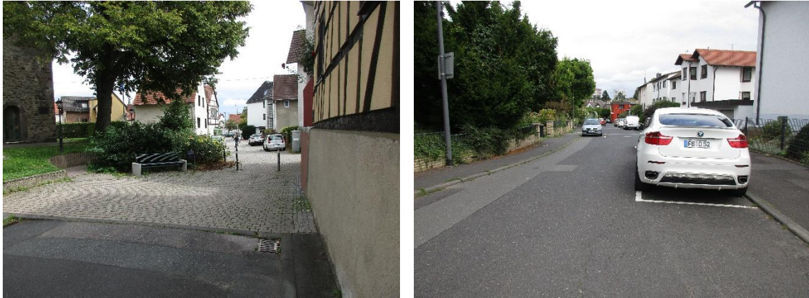
Abb. 39: Bestandssituation Kirchgasse (beispielhaft), eigene Aufnahmen werkplan, August 2021
