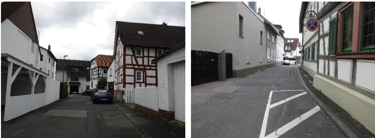
Abb. 40: Bestandssituation Schwanengasse (beispielhaft), eigene Aufnahmen werkplan, August 2021
