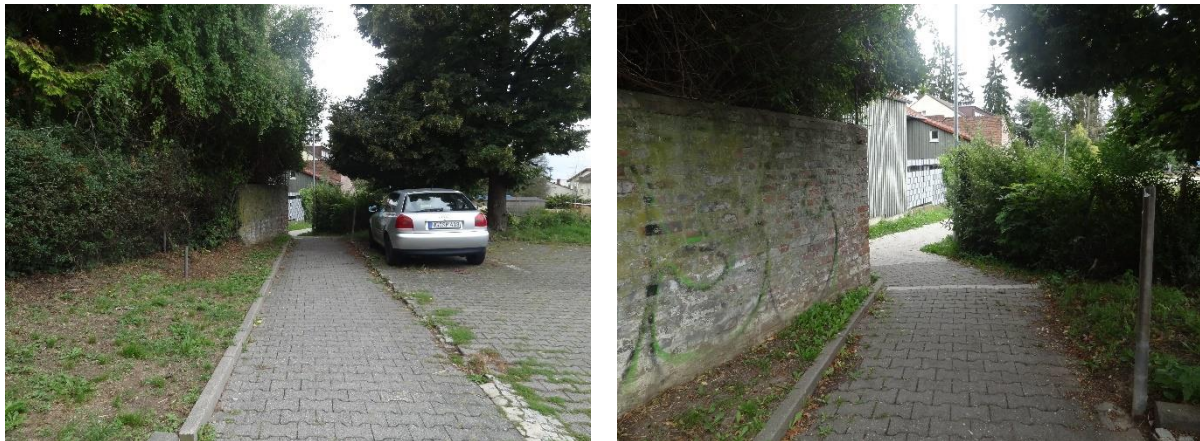
Abb. 47: Bestandssituation Fußweg Bahnstraße - Wiesenstraße, eigene Aufnahmen werkplan, August 2021
