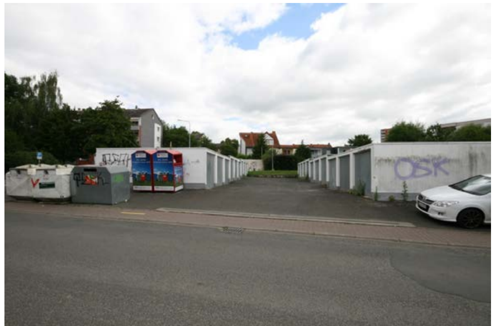
Garagenplätze am Hessenring
