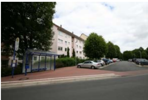
Berliner Straße / Hochhaus
