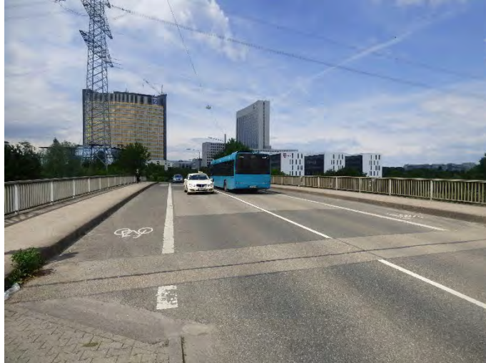
Abb. 12 Querungsstelle der BAB A66: Wilhelm-Fay-Straße
