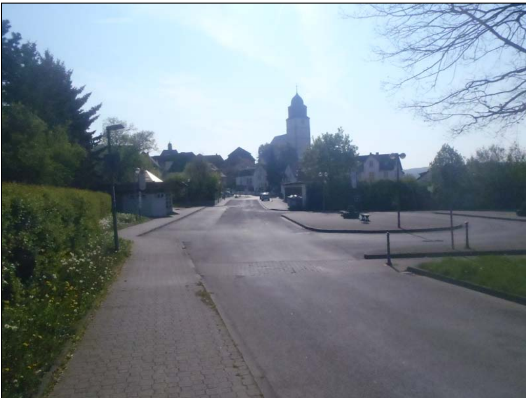
Abb. 7: Busbahnhof mit Buswartehalle
