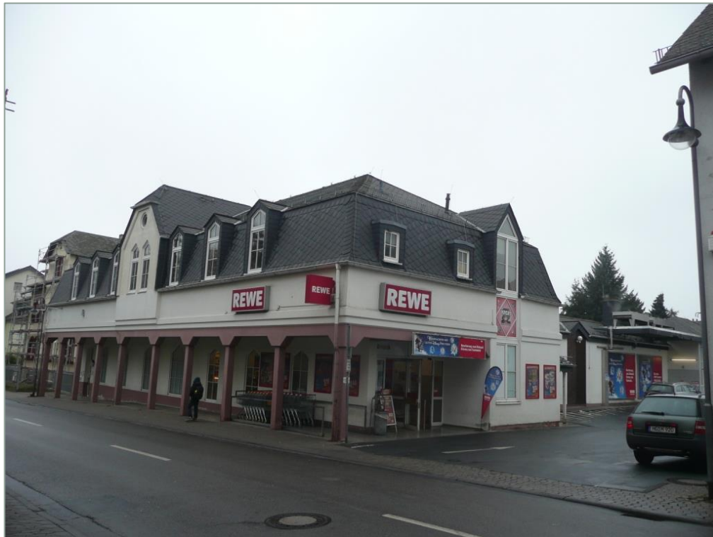
Abbildung 10: Leergezogener Rewe-Markt, Neutorstraße, Innenstadt Usingen (Zone 1)
