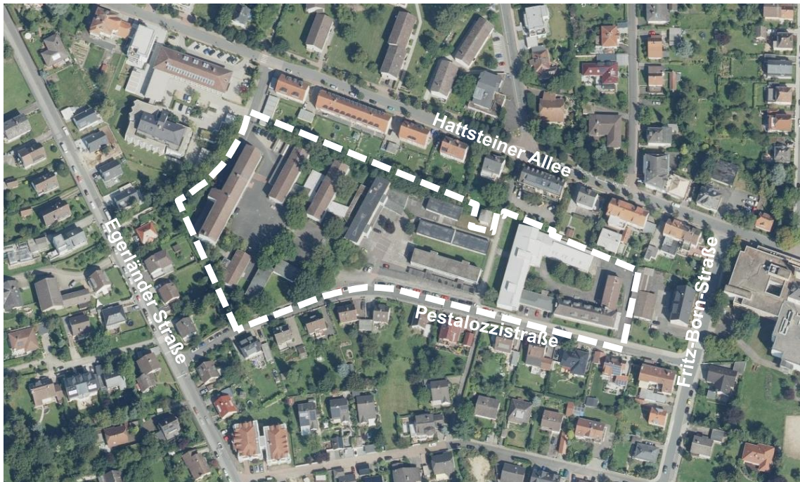
Abbildung: Luftbild / Lage des Plangebiets in der Umgebung, nicht maßstäblich. © Luftbild: Hessische Verwaltung für Bodenmanagement und Geoinformation
