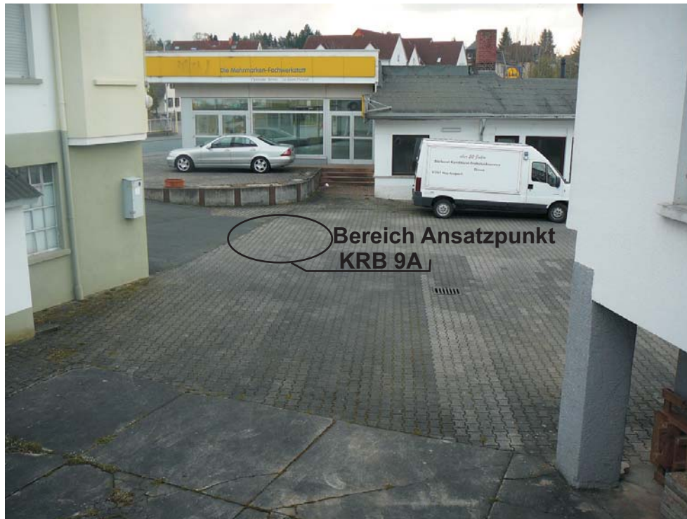
Bild 05: Blick auf den Bereich der ehem. Tankstelle. Augenscheinlich sind keine technischen Einrichtungen der Tankstelle (Domschächte, alte Befüllstutzen o.ä.) erkennbar (Blickrichtung: Süd, Aufnahmedatum: 07.04.14)
