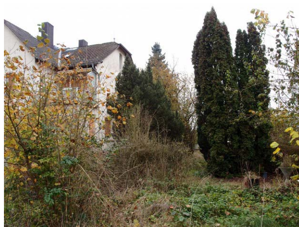
Foto 9: Blick auf Neutorstraße 16 vom Garten aus
