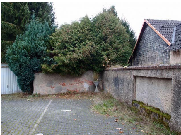
Foto 8: Neutorstraße 16, Hof / Zufahrt östlich des Gebäudes
