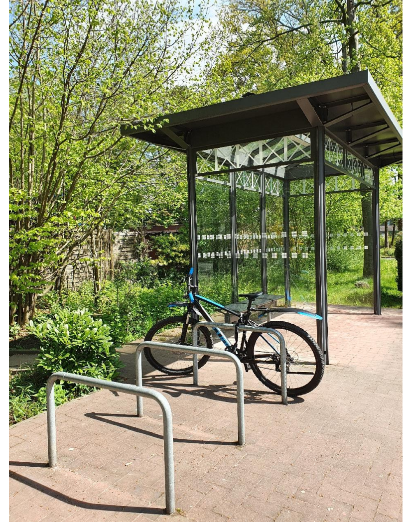
Beispiele Fahrradabstellanlagen an einer Haltestelle (eigene Aufnahme)
