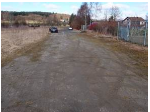
Foto 6: Erschließungsweg, Flurstück 88/2, Blickrichtung Norden. Teilbereich A im westlichen Bildteil, mit östlich anschließenden Nachbargrundstücken (Teilbereich B).
