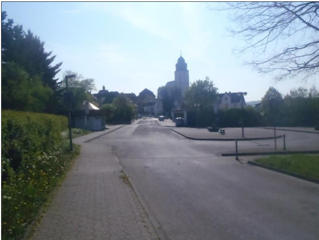
Abbildung 29: Busbahnhof mit Buswartehalle
